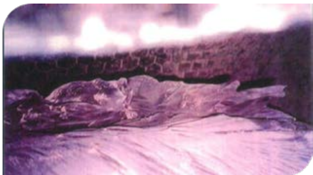
Figura 3: Coque formado no interior de ciclone. Fonte: Banco de imagens FCCSA
